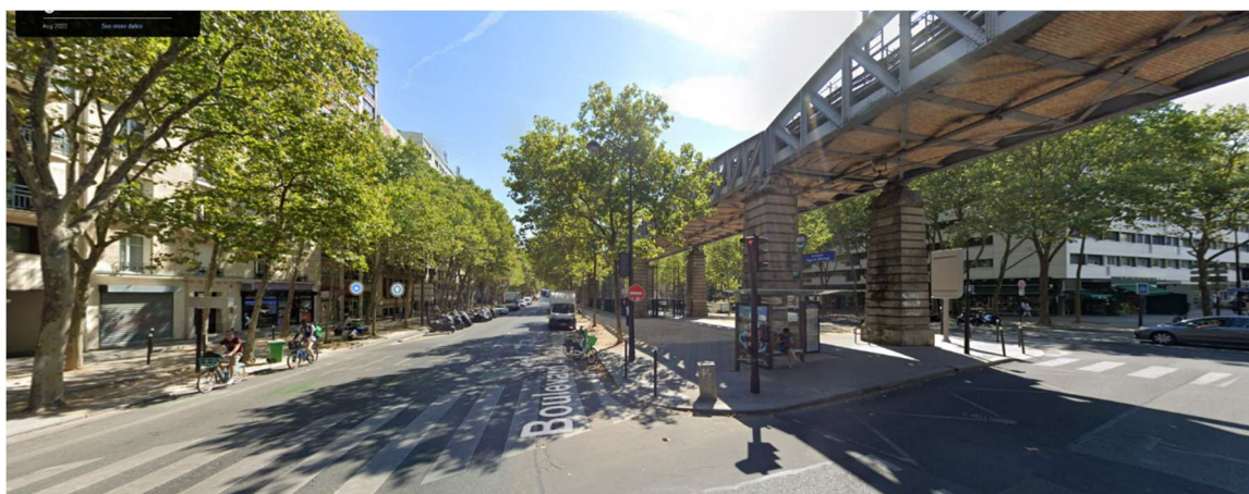
Figure 54. Paris, métro aérien de la ligne 6, boulevard Auguste Blanqui d'une largeur de 70 mètres
