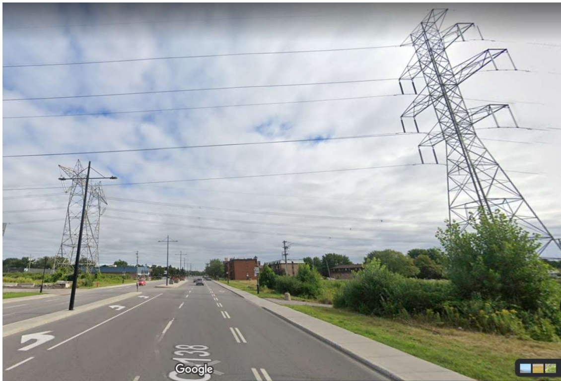
Figure 21. Ligne de transport de haute tension électrique, rue Sherbrooke Est, entre les 36 e et 39 e avenues.
