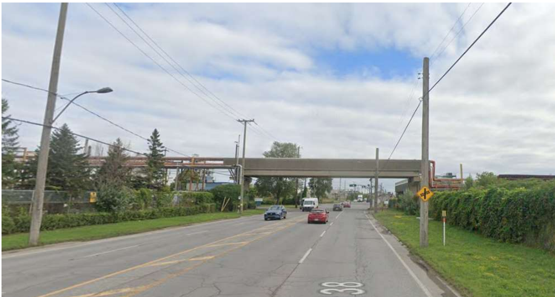
Figure 20. Râtelier d'oléoducs traversant la rue Sherbrooke Est, entre les avenues Gamble et Durocher
