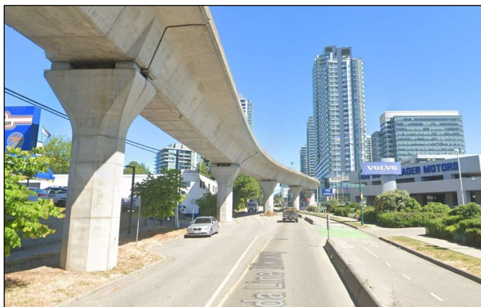
Figure 39. SkyTrain de Vancouver - Exemple du franchissement d'une rue par l'infrastructure aérienne et de son impact visuel sur la perspective de la rue
