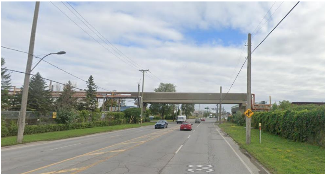
Figure 20. Râtelier d'oléoducs traversant la rue Sherbrooke Est, entre les avenues Gamble et Durocher
