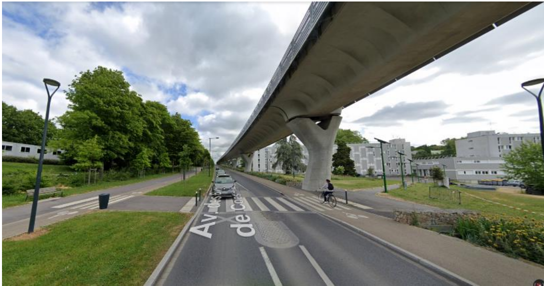
Figure 53. Rennes, ligne B, intégration paysagère et réduction du nombre de voies de circulation
